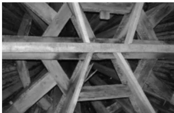
BJFI-005 Le moulin de Pointe-aux-Trembles, détail de la structure du toit.
