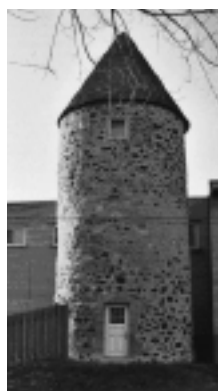
BJFI-005 Le moulin de Pointe-aux-Trembles lors du relevé architectural effectué en 2001, pour une mise en protection.
