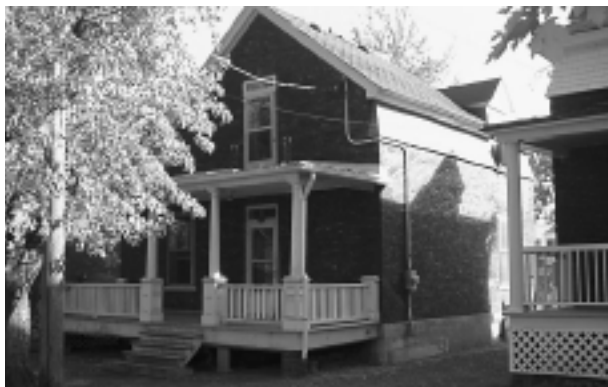
11.E. 5 Un cottage détaché situé au 544, 6 e Avenue (Société des logements ouvriers)
