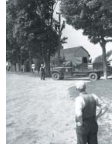
Monteurs de ligne au travail en 1947 Archives Hydro-Québec, fonds Shawinigan Water and Power Co.
