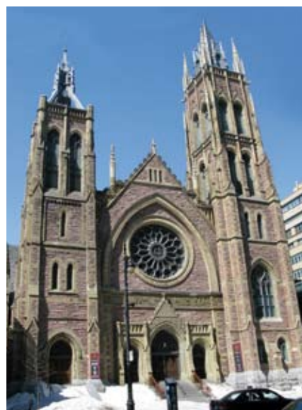
Figure 36. Façade de l'église unie Saint-James après les travaux de restauration. © CPRQ, 2003
